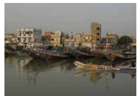
Fig. 4 Le quartier des pêcheurs de Saint-Louis (Sénégal) est particulièrement vulnérable à l'élévation du niveau de la mer – Photo E. Piguet
